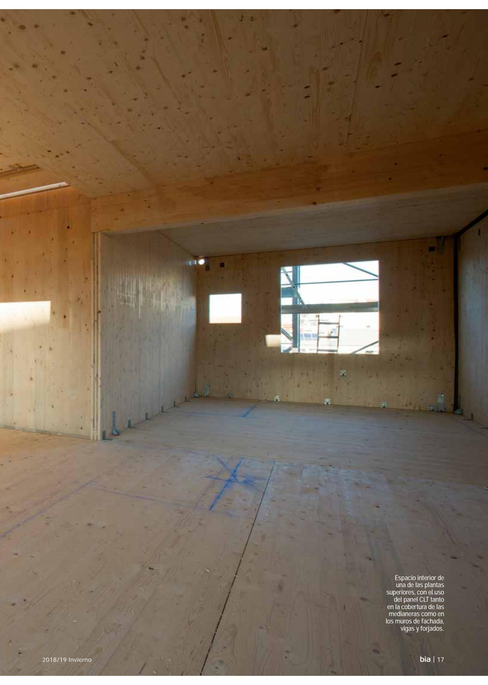
Espacio interior de una de las plantas superiores, con el uso del panel CLT tanto en la cobertura de las medianeras como en los muros de fachada, vigas y forjados.
