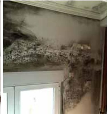
**El fenómeno de condensación se** produce cuando el aire cargado de humedad entra en contacto con una superficie que tiene una temperatura igual o inferior a la conocida como temperatura de rocío. En ese momento, el aire se satura de humedad y se desprende de ella, depositándose sobre esa superficie.
