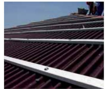
El modelo de placa Onduline utilizado en este proyecto ha sido el DRS BT-50; un tipo de placa especialmente diseñada para resistir cargas pesadas y la colocación de todo tipo de tejas con encaje. Las placas Onduline Bajo Teja DRS BT-50 son muy resistentes al pisado, permitiendo transitar cómodamente por la cubierta para repartir los listones que servirán de soporte a las tejas.
